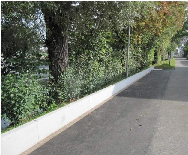
Abb. 3: Beispielfotos für Ufererhöhungen mit Winkelplatten (links) und Blocksteinmauer (rechts)
