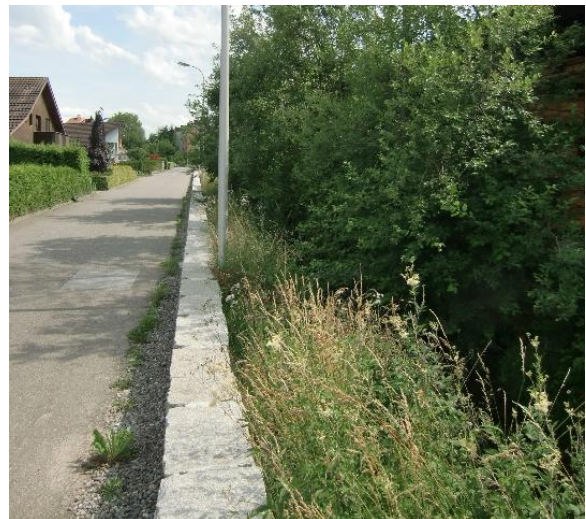
Abb. 3: Beispielfotos für Ufererhöhungen mit Winkelplatten (links) und Blocksteinmauer (rechts)
